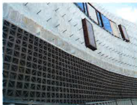
Campus universitaire travaux
