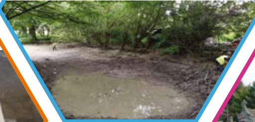
Nettoyage de l'étang du Bois des Soeurs
